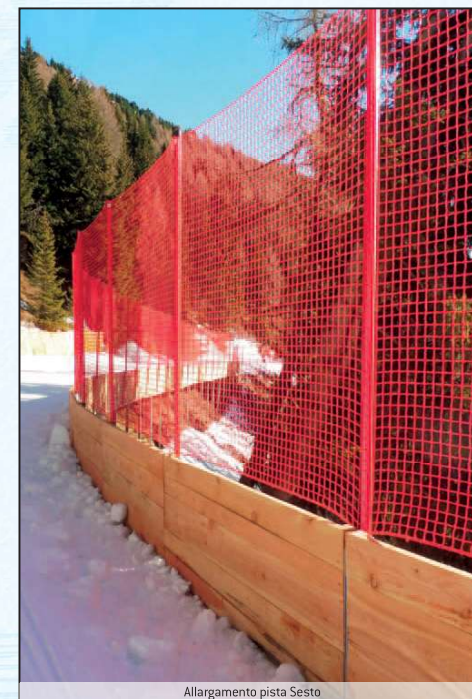
Allargamento pista Sesto
