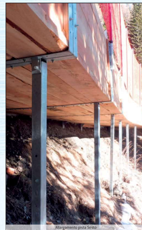
Allargamento pista Sesto
