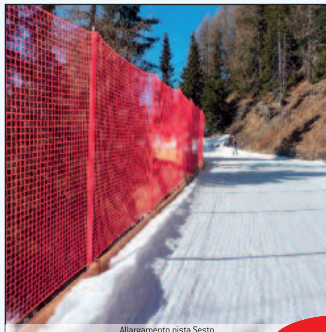
Allargamento pista Sesto
